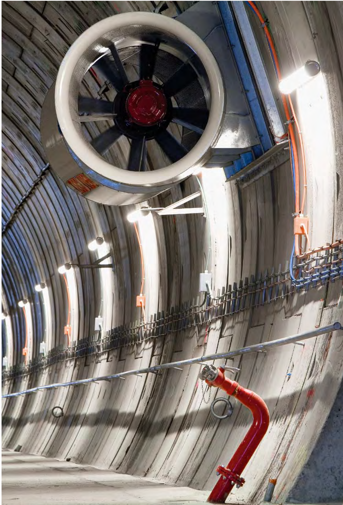
32 Eiffage / SNCF, Perthus Tunnel (FR)
