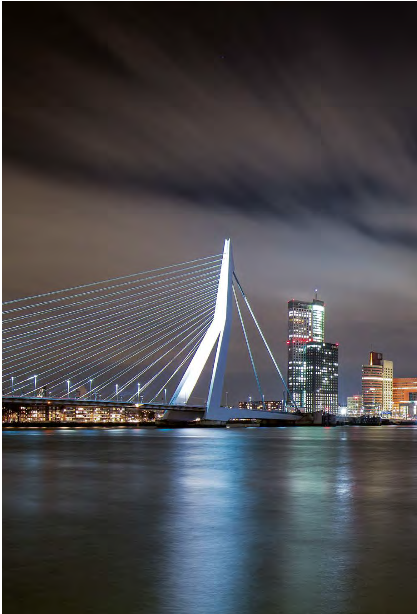
38 Erasmus Brücke, Rotterdam (NL), UNStudio, ATCLD
